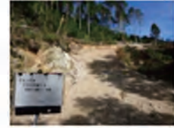
(森林作業道補修支援) 作業完了後
