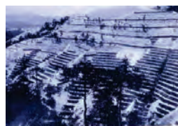
山腹工の施工 (1917年)
