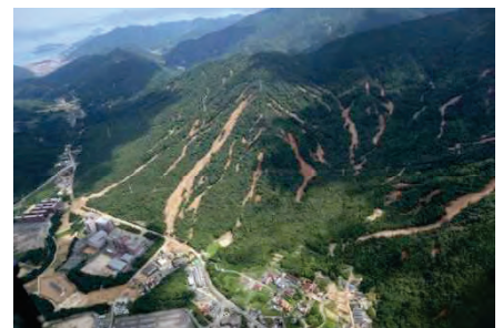
平成30年7月豪雨 (広島県東広島市)
