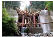
流木捕捉式治山ダムの整備
