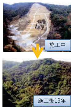
山腹工等による崩壊地の復旧 (香川県小豆島町)
