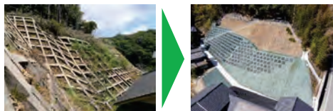
老朽化した施設を更新し、山腹斜面の安定度を向上（広島県尾道市）
