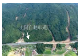
「平成30年7月豪雨」による荒廃状況
