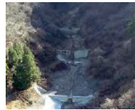
小規模な治山ダムを階段状に配置
