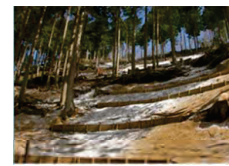
柵工による斜面補強対策
